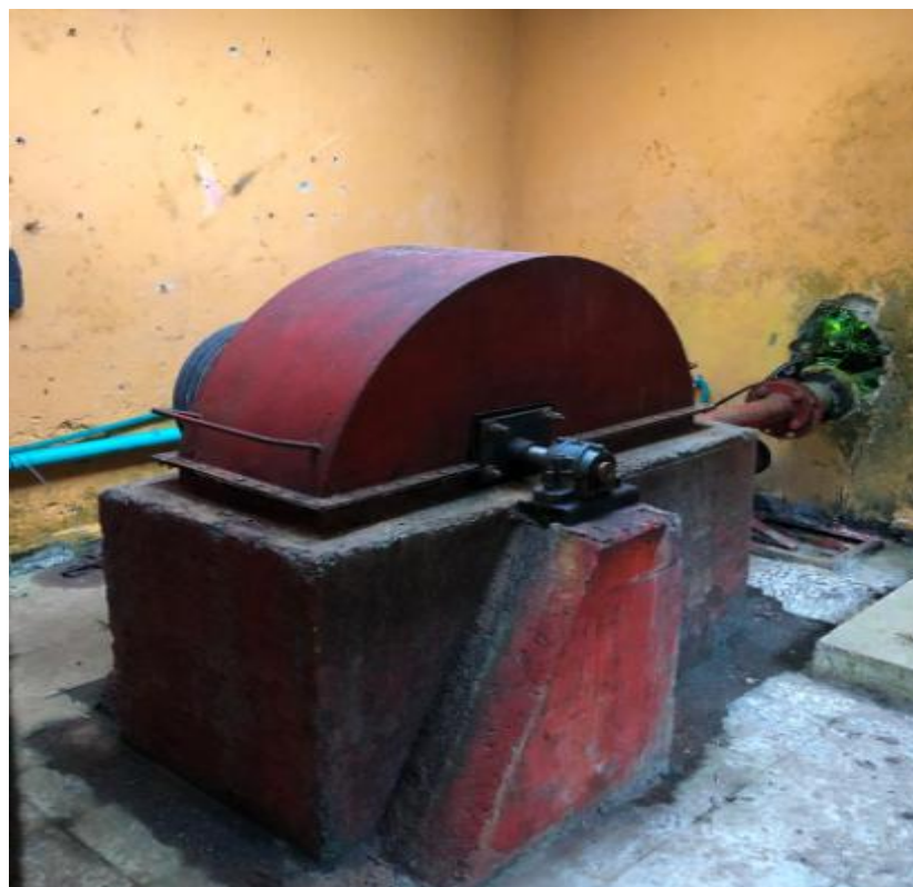
Imagen 19 .Estado actual de la red eléctrica. Fuente: GI PNNC
