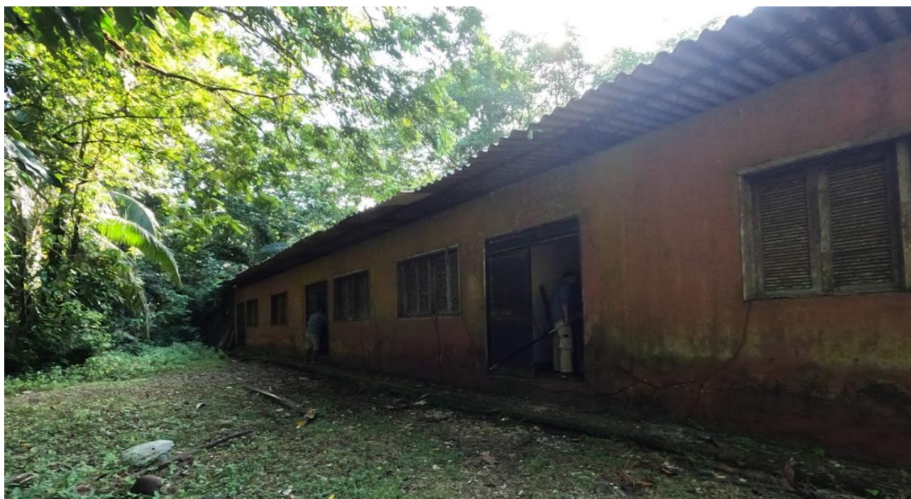
Imagen 11. Bodega exterior. Fuente: GI PNNC
