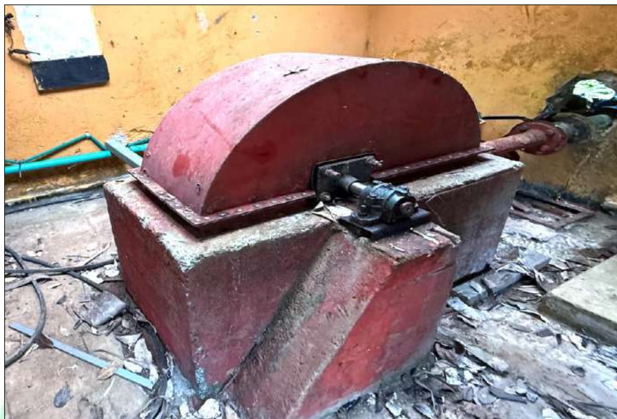
Ilustración 3. Turbina PCH Existente. Fuente: Consultor IMAC de Colombia SAS
