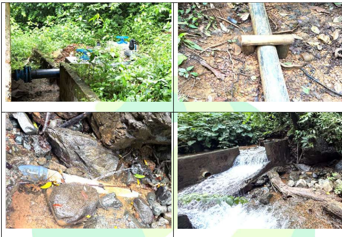
Ilustración 6. Sistema de Captación y Transporte de Agua para PCH. Fuente: Consultor IMAC de Colombia SAS
