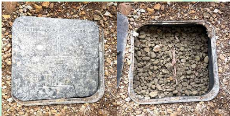
Ilustración 15. Sistema de Puesta a Tierra Existente edificación Renovada. Fuente: Consultor IMAC de Colombia SAS
