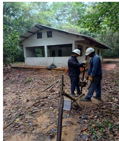
FOTOGRAFIA 2. Ejecución de la perforación
