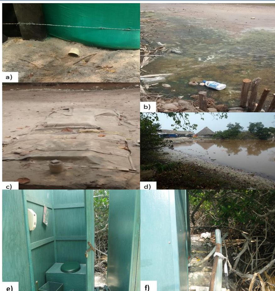
Figura 51 Descargas directas de aguas servidas, b) aspecto negativo de las lagunas de la zona debido a la contaminación, c) sistemas de tanques sépticos usados en algunas estructuras y d) infraestructura cercanas a las lagunas, d) baños utilizados en la playita de cholón f) tubería de desagüe de los baños. Fuente PNNCRSB, 2016.
