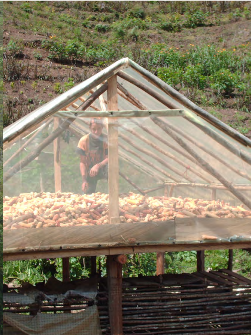
Horno solar (marquesina) construido para el secado y la conservación de productos. Fuente: Ángela Gómez.
