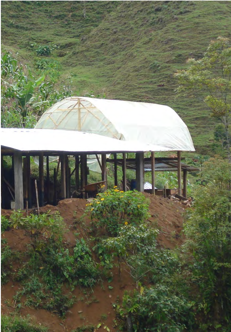
Infraestructura agropecuaria construida en la finca de Jaime Quiroz, establo y marquesina. Fuente: Catalina Zapata.
