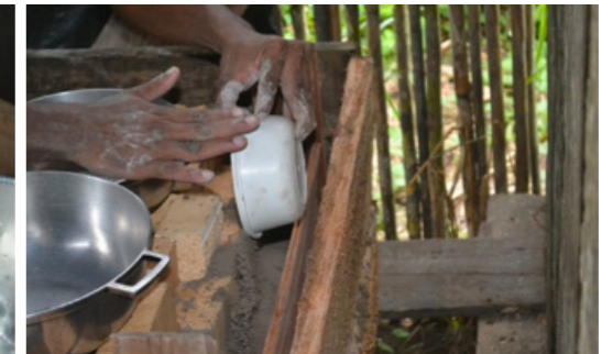
55 Vaceando la ceniza en la formaleta interna
