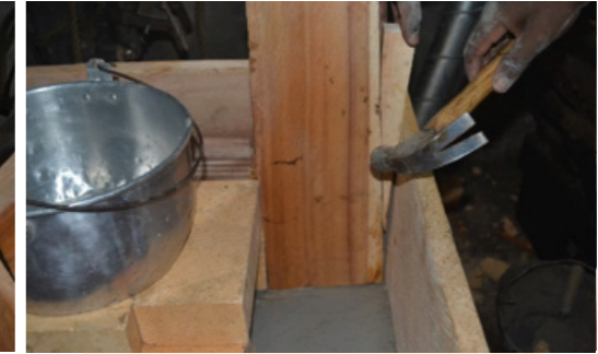
53 Pedazos de tablas que contienen la mezcla cerca de la entrada de la cámara de combustión
