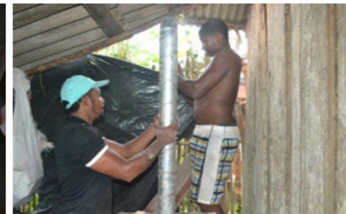
60 Instalando tubo de desfogue
