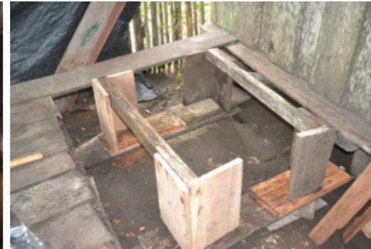
8 Soportes con patas de tablas terminados
