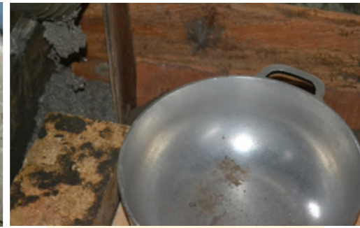
57 Vacinando la mezcla en las esquinas de la formaleta
