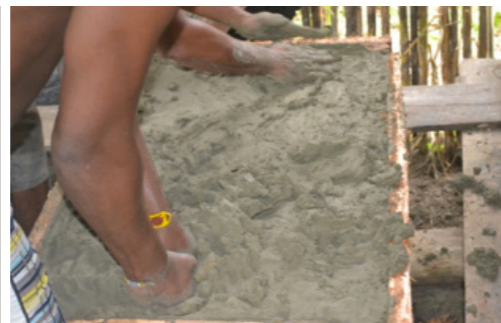
20 Compactando la mezcla con las manos
