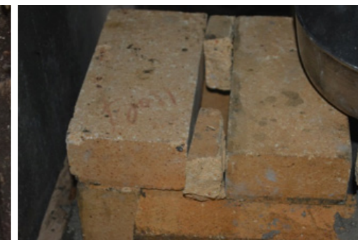
40 Ubicando pedazos de ladrillos para soporte de tubo del desfogue
