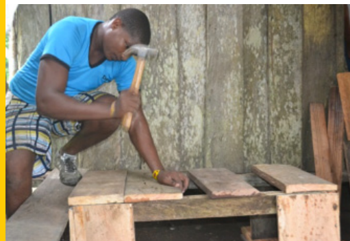
10 Pegando las tablas al soporte de la base del fogón
