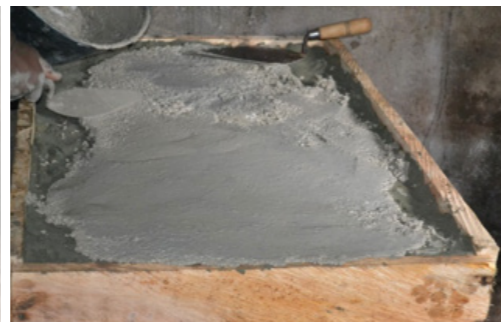
22 Capa de cemento refractario
