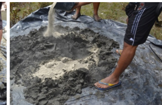
16 Agregando el cemento gris a la mezcla
