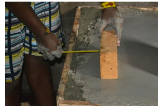
23 Ubicando los primeros ladrillos a quince (15) centímetros del borde
