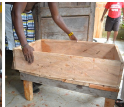
12 Ubicando la formaleta encima del piso de la base del fogón
