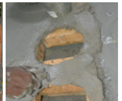
65 Mezcla un poco más gruesa y seca para dar la forma redondeada a las hornillas
