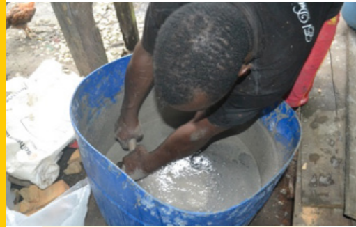
56 Haciendo la mezcla
