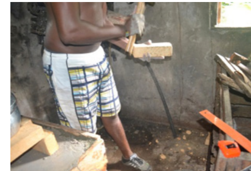
30 Partiendo el medio ladrillo para la barrera de aislamiento de la segunda hornilla
