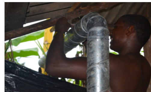
61 Amarrando el tubo de desfogue con alambre dulce o chispa
