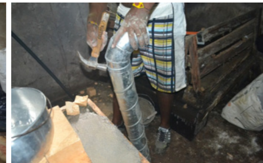
45 Instalando los codos
