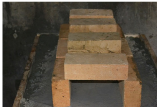
26 Ladrillos con los que se estructuran las hornillas
