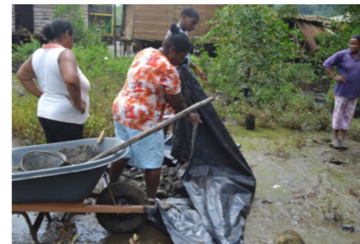
17 Moviendo el plástico para formar la masa
