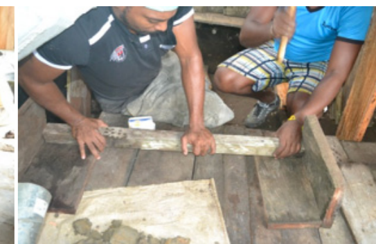
6 Armado de soporte con patas de tabla
