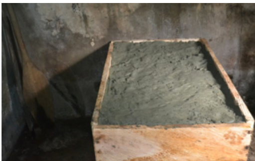
21 Cama rellena con mezcla de barro, arena y cemento gris
