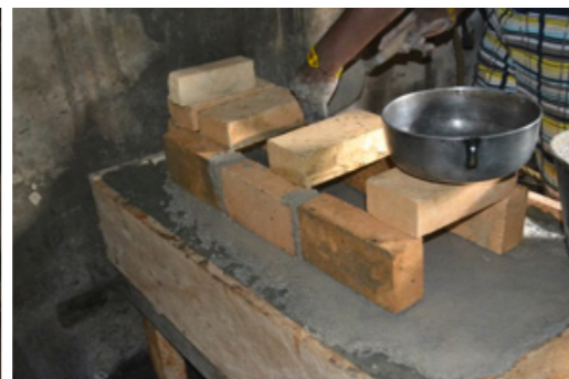
29 Pegando los ladrillos con la mezcla
