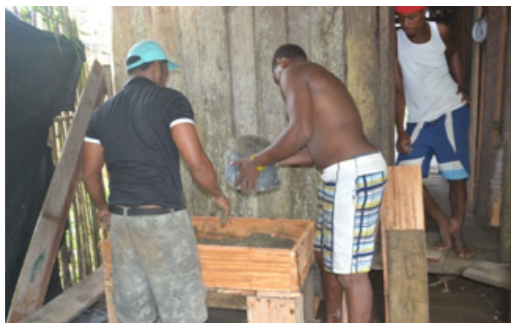
19 Rellenando la cama con cemento
