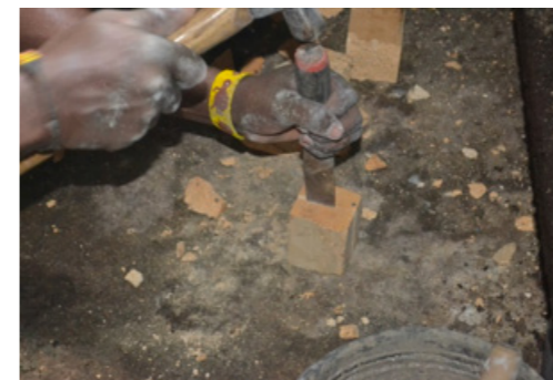
39 Partiendo pedazos de ladrillos para soporte del tubo de desfogue
