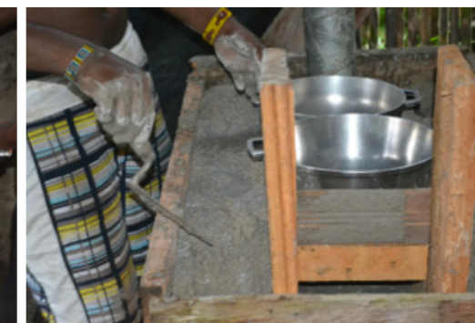
64 No olvide que las ollas deben permanecer en su posición
