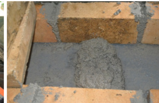
31 Mezcla para ladrillo de barrera de aislamiento de la segunda hornilla
