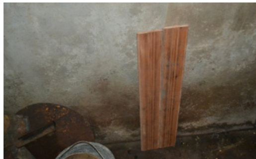
50 Machimbre para formaleta interna
