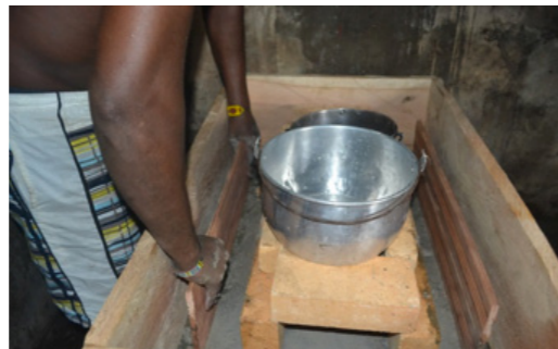
51 Ubicando formaleta interna
