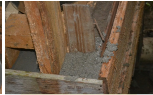
58 Esquina de la formaleta con mezcla
