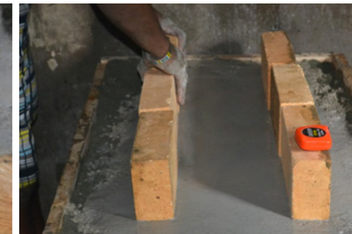
25 Ubicando el resto de los ladrillos en línea recta
