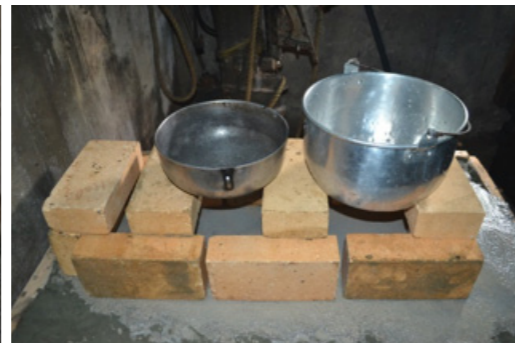
27 Las ollas sirven para definir el tamaño de las hornillas
