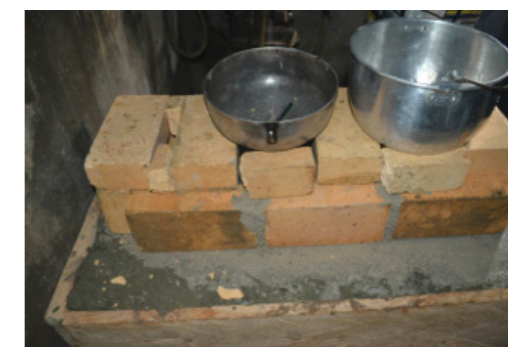
41 Estructura de la cámara de combustión terminada
