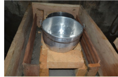
52 Formaletas internas y externas instaladas
