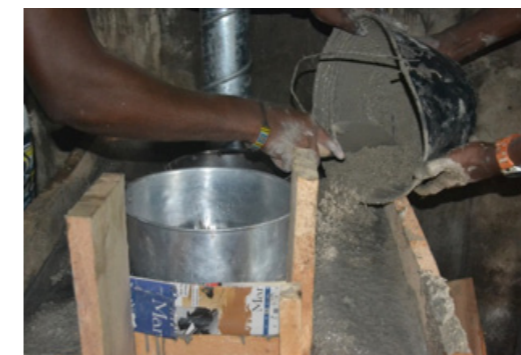
63 Vertido de la mezcla sobre la cámara de combustión
