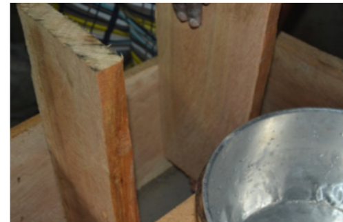
54 Detalle de las tablas que contienen mezcla cerca de la entrada de la cámara de combustión
