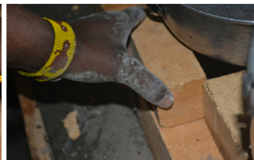
38 Ubicando ladrillos para terminar de formar las hornillas
